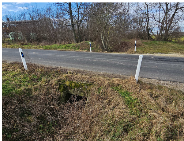
A 0282/5 hrsz árok és áteresze 0289 hrsz-től északra
